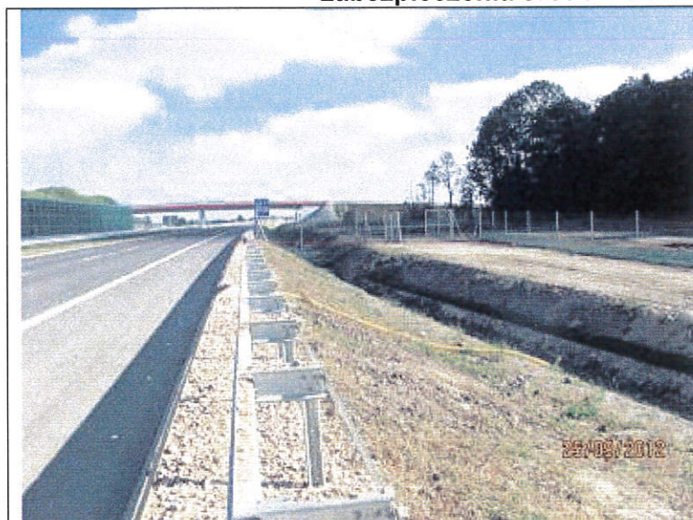
km 217+500 – montaż ogrodzenia dogęszczającego w rejonie szlaków migracji płazów
