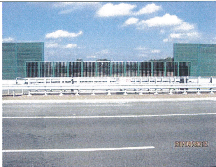
Km 223+695 – ekrany nad obiektem E7 zabezpieczające kolizji z ptakami
