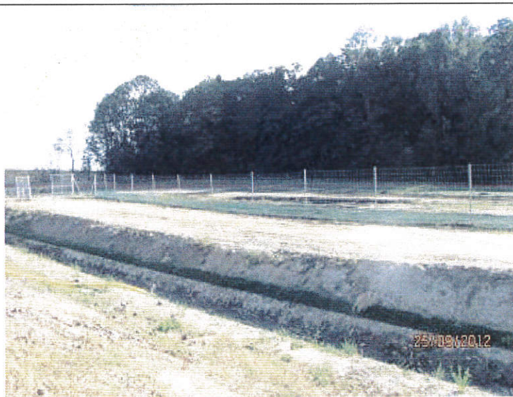
Km 218+500 – montaż ogrodzenia i siatki dogęszczającej w rejonie szlaków migracji płazów
