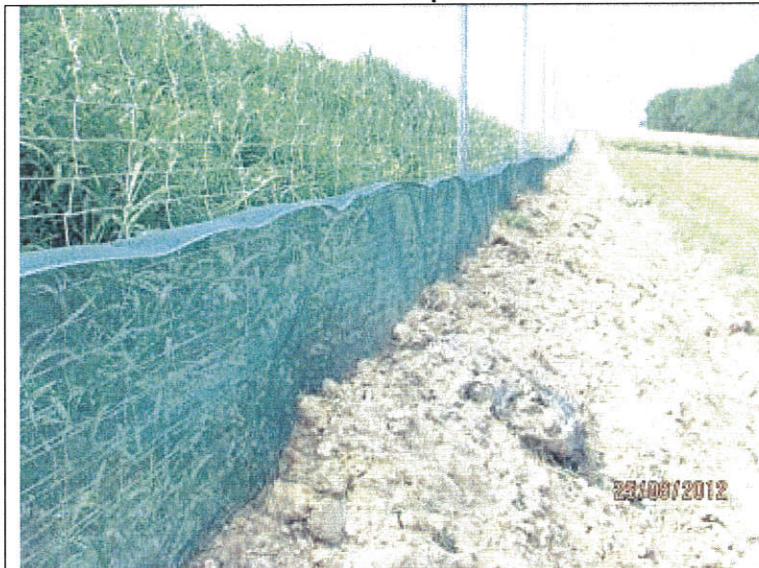
Km 218+200 – montaż ogrodzenia dogęszczającego w rejonie szlaków migracji płazów
