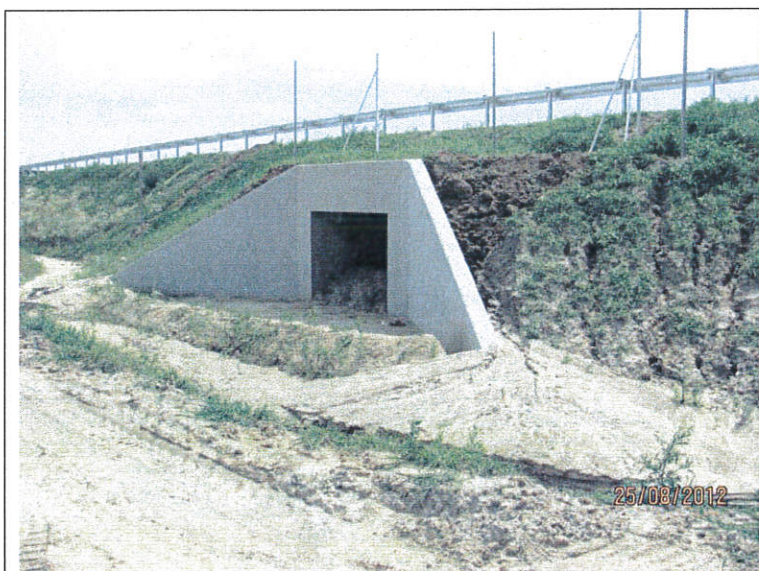
PZD 18 - km 217+980.00 otoczenie przepustu pełniące funkcję ekologiczną.
