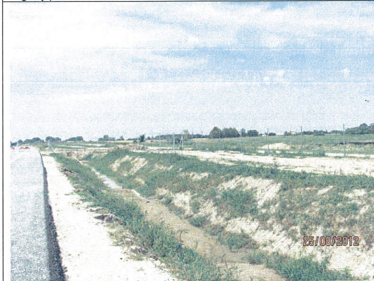
Km 218+500 – montaż ogrodzenia i siatki dogęszczającej w rejonie szlaków migracji płazów
