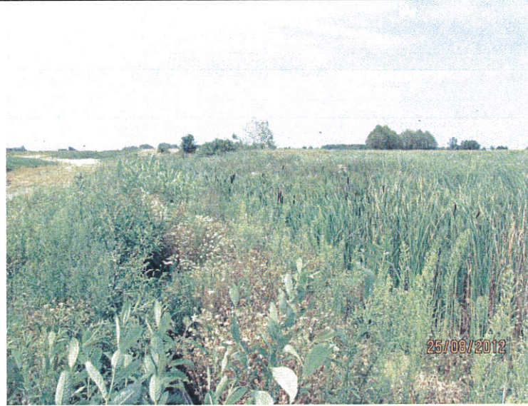
Km 218+500 – stan ogrodzenia tymczasowego w rejonie szlaków migracji płazów
