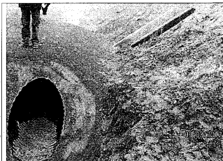
Pe8 w km 237+400 profilowanie terenu przed przepustem dla płazów
