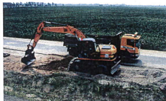
Fot. 5. Równanie pobocza po prawej stronie pasa drogowego ok. km 224+400.
