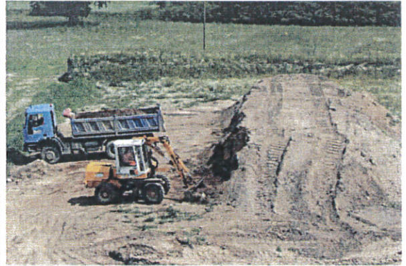
Fot. 8. Wywożenie hałdy po lewej stronie pasa drogowego, ok. km 241+500.
