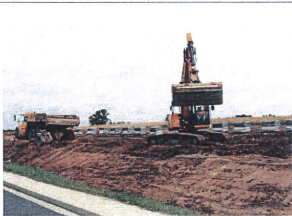
Fot. 9. Profil rowu odwadniającego po lewej stronie pasa drogowego, ok. km 240+000.
