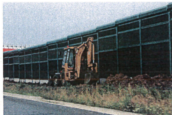
Fot. 4. Prace ziemne po prawej stronie pasa drogowego, ok. km 219+800.
