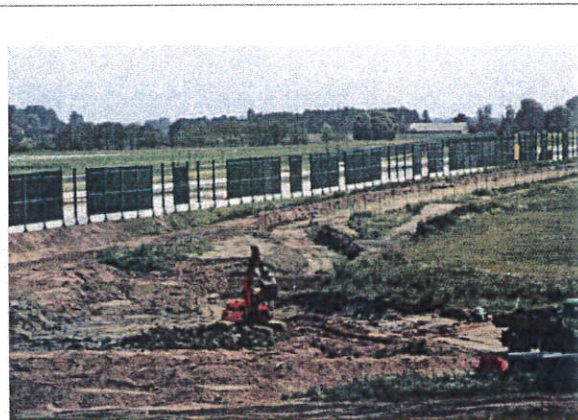
Fot. 1. Prace ziemne związane z budową zbiornika retencyjnego ZR 03 w rejonie węzła Kowal.
