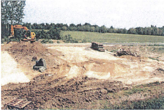
Fot. 7. Prace ziemne po lewej stronie pasa drogowego, ok. km 234+700.
