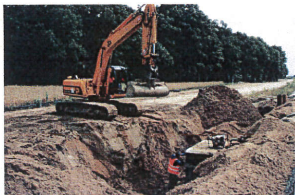
Fot. 3. Prace ziemne u wylotu przepustu PA-5, po lewej stronie pasa drogowego.
