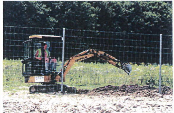
Fot. 10. Kopanie wykopu pod siatkę dogęszczającą po prawej stronie pasa drogowego, ok. km 244+200.
