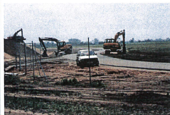
Fot. 6. Prace ziemne po prawej stronie pasa drogowego w rejonie obiektu WD 187.
