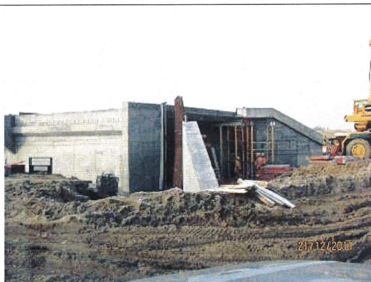
Postęp robót na obiekcie E-7, przejście dla zwierząt, km 223+695
