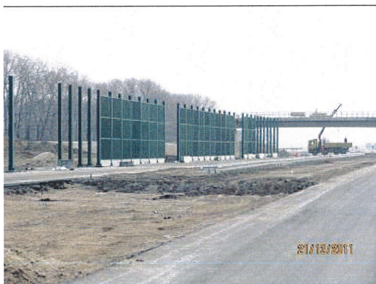
Postęp robót na obiekcie PG-195A przejście dla zwierząt, km 237+700,00
