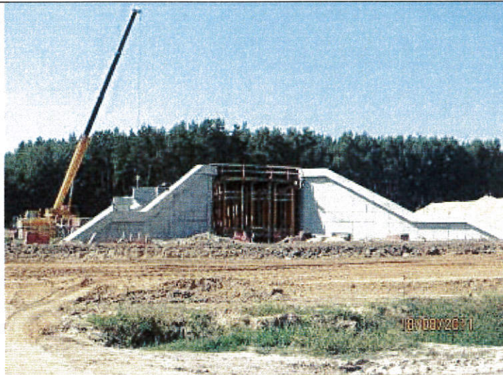
Postęp robót na obiekcie E-6, przejście dla zwierząt, km 222+190
