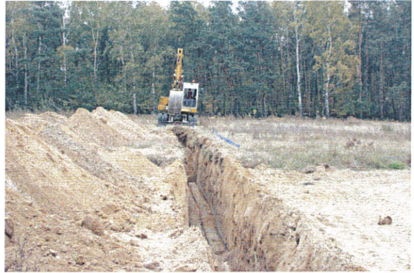
Fot. 8. Wykop pod instalację elektroenergetyczną w obrębie MOP Strzelce Płn., km 238+350, widok od strony zachodniej.
