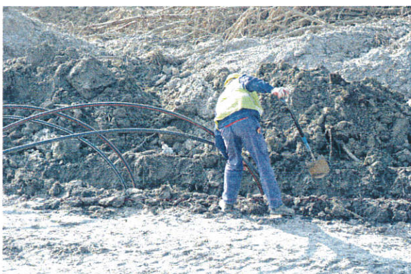
Fot. 3. Prace związane z budową łączności optotelekomunikacyjnej, km 219+200, widok od strony północno- wschodniej.
