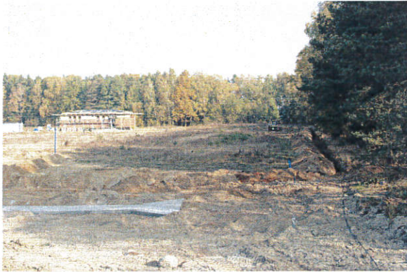
Fot. 7. Wykop pod instalację elektroenergetyczną w obrębie MOP Strzelce Płn., km 238+350, widok od strony południowej.
