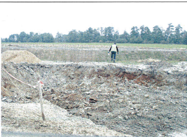
Fot. 5. Wykop pod ZR_19, km 227+400, widok od strony południowo-zachodniej.
