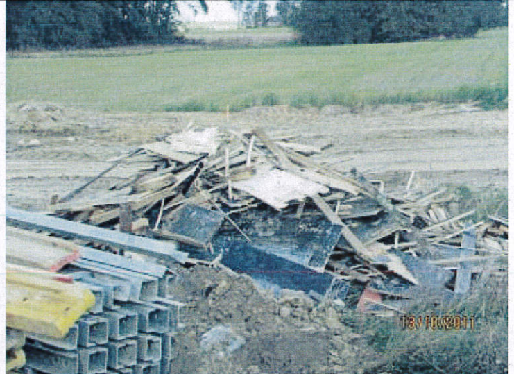
km 228+880 segregacja odpadów budowlanych, tymczasowe miejsce składowania odpadów drewnianych
