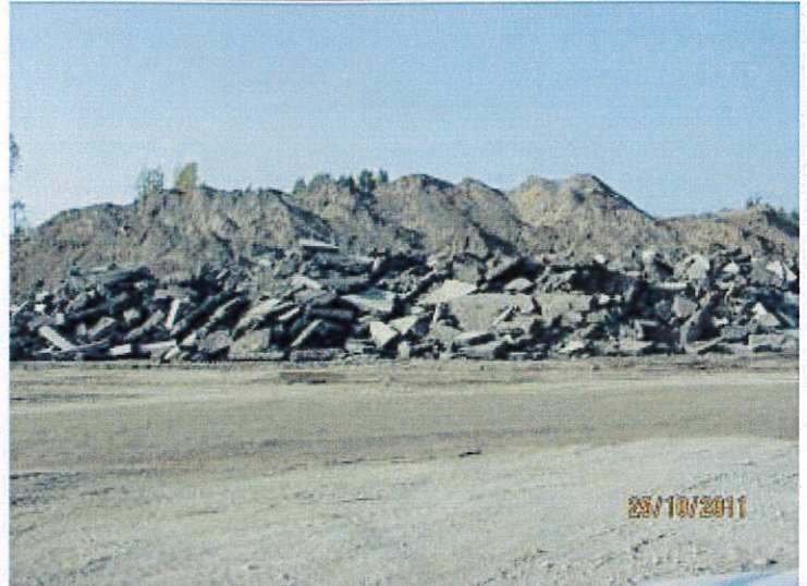
km 233+100, segregacja odpadów budowlanych, tymczasowe miejsce składowania niewykorzystanego betonu asfaltowego
