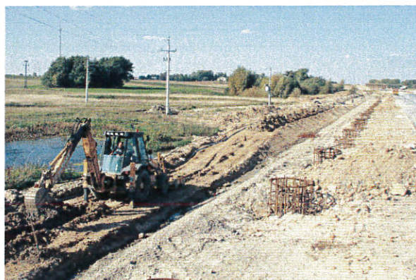
Fot. 4. Prace ziemne przy budowie łączności optotelekomunikacyjnej, km 219+400, widok od strony wschodniej.
