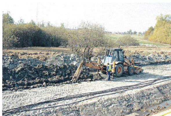
Fot. 2. Prace ziemne przy budowie łączności optotelekomunikacyjnej, km 219+200, widok od strony wschodniej.
