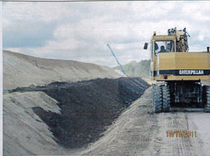
km 224+500 humusowanie skarp autostrady
