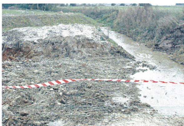
Fot. 6. Wykop pod ZR_19, km 227+400, widok od strony południowo-zachodniej.
