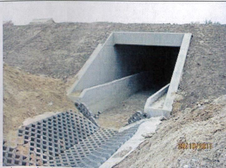
wykonywanie połączeń przepustu PZ 3 z km 233+810 z półkami dla płazów z rowem melioracyjnym
