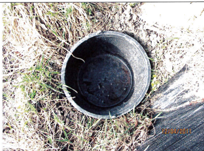
Kontrola pułapek do odłowu migrujących płazów, km 220+700
