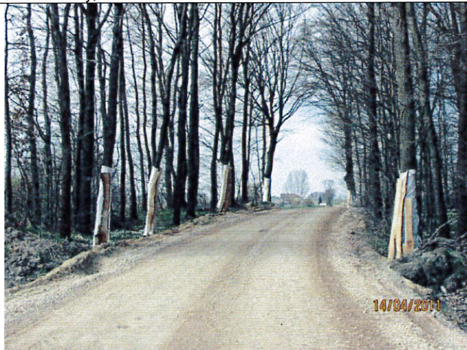
Zabezpieczenia drzew, km 224+800
