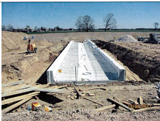
Przepust, montaż gabionów, km 229.
