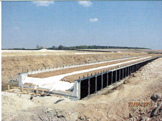
Przepust, montaż gabionów i obsypywanie ziemią, km 222+700
