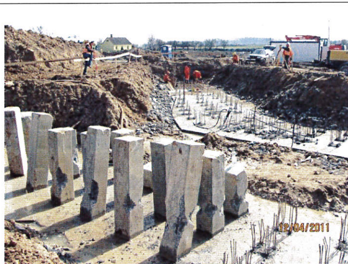
Postęp robót na obiekcie E-6, przejście dla zwierząt, km 222+195
