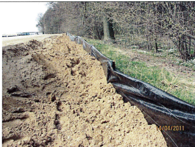
Kontynuacja montażu siatki ograniczającej możliwość wejścia płazów na teren budowy, km 224+900
