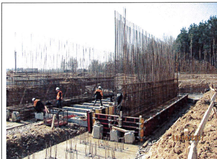
Postęp robót na obiekcie E-6, przejście dla zwierząt, km 222+195
