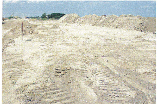
Fot. 8. Działkowo st. 10, gm. Lubień Kujawski. Wschodnia część stanowiska archeologicznego po zakończeniu badań i zasypaniu.
