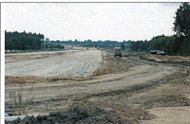
Fot. 1. Niedrzew II st. 20, gm. Strzelce Prace budowlane wznowione w miejscu gdzie znajdowało się stanowisko archeologiczne. Widok od strony północno-zachodniej.
