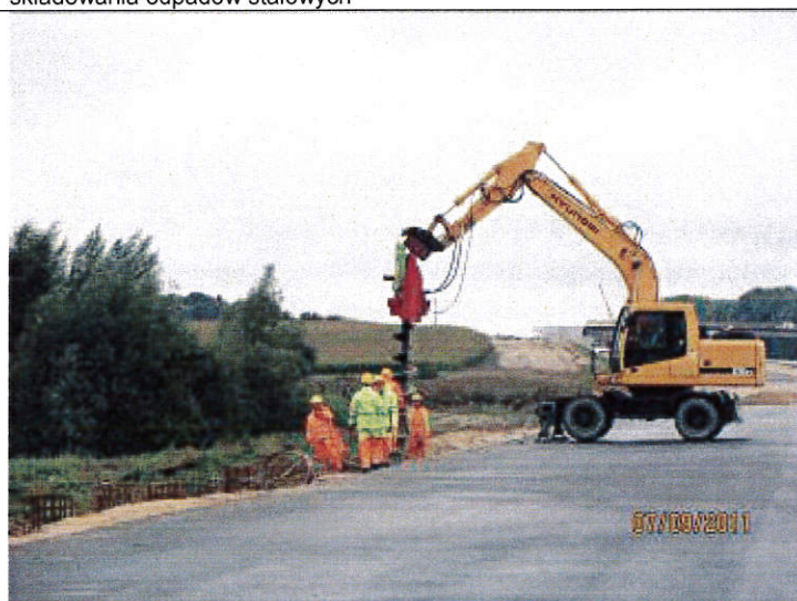
Km 219+100, wykonywanie odwiertów pod fundamenty ekranów akustycznych
