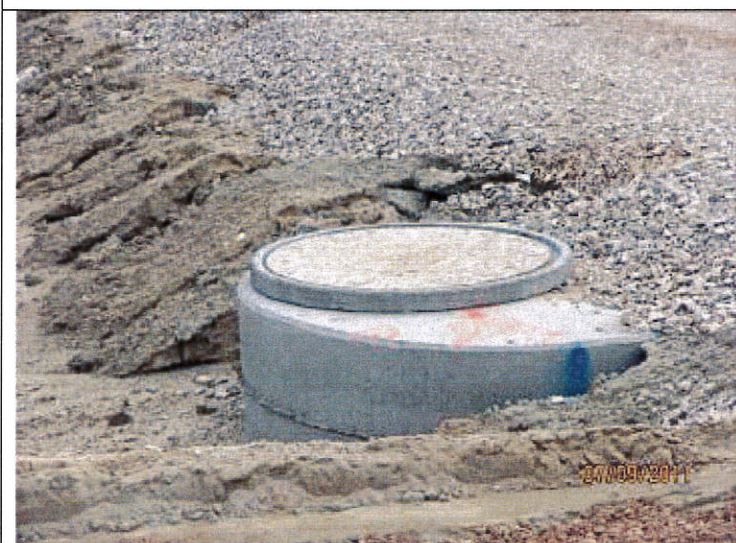
Zabezpieczenie wlotu studzienek kanalizacyjnych
