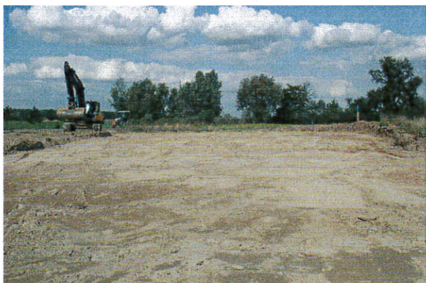
Fot. 5. Pas pod DD 4/15, km 222 +900 w trakcie odhumusowywania, widok od strony południowej.
