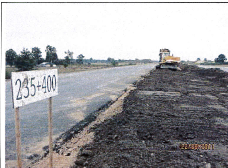
km 235+400 humusowanie pasa dzielącego autostrady
