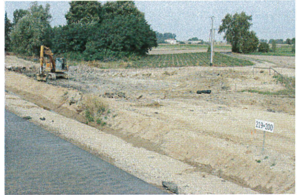
Fot. 8. Odhumusowanie pod ZR_05, km 219+200, widok od strony południowej.
