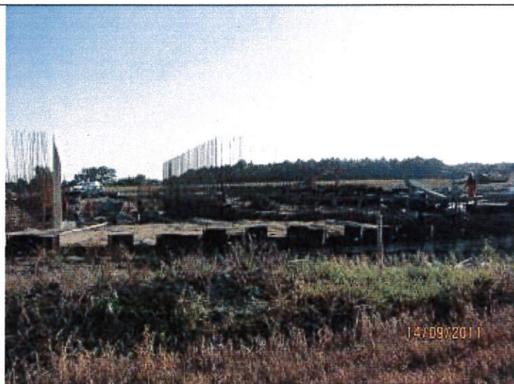
Postęp robót na obiekcie E-7, przejście dla zwierząt, km 223+695
