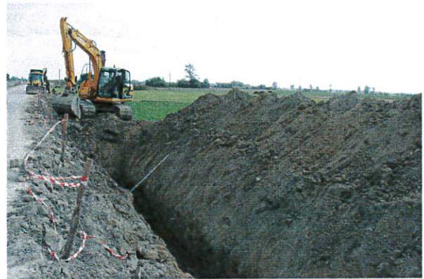
Fot. 10. Prace ziemne przy budowie kanału hydrotechnicznego, km 230+600.
