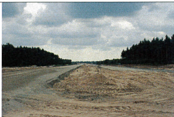
Fot. 2. Niedrzew II st. 20, gm. Strzelce Prace budowlane wznowione w miejscu gdzie znajdowało się stanowisko archeologiczne. Widok od strony północnej.
