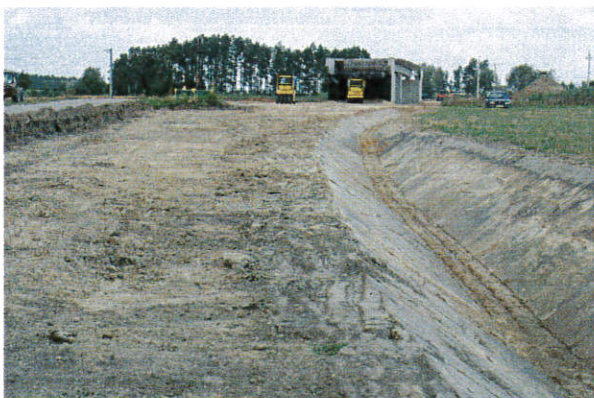
Fot. 6. Odhumusowany pas pod DD 4/18, w rejonie obiektu WD 185, widok od strony południowej.
