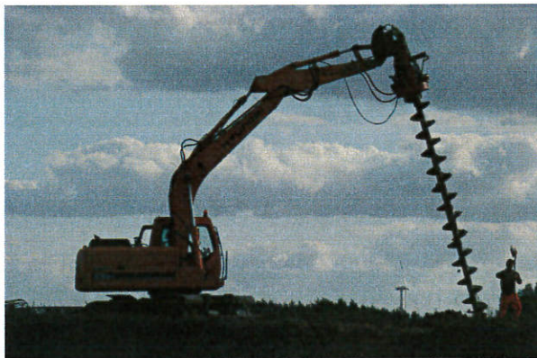
Fot. 9. Wiercenie pod konstrukcje ekranów akustycznych km 217+500.
