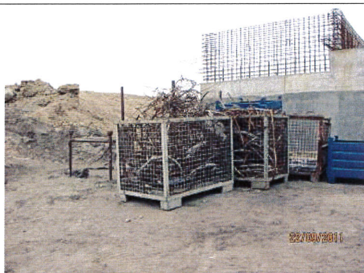
km 240+888,48, segregacja odpadów budowlanych, tymczasowe miejsce składowania odpadów stalowych
